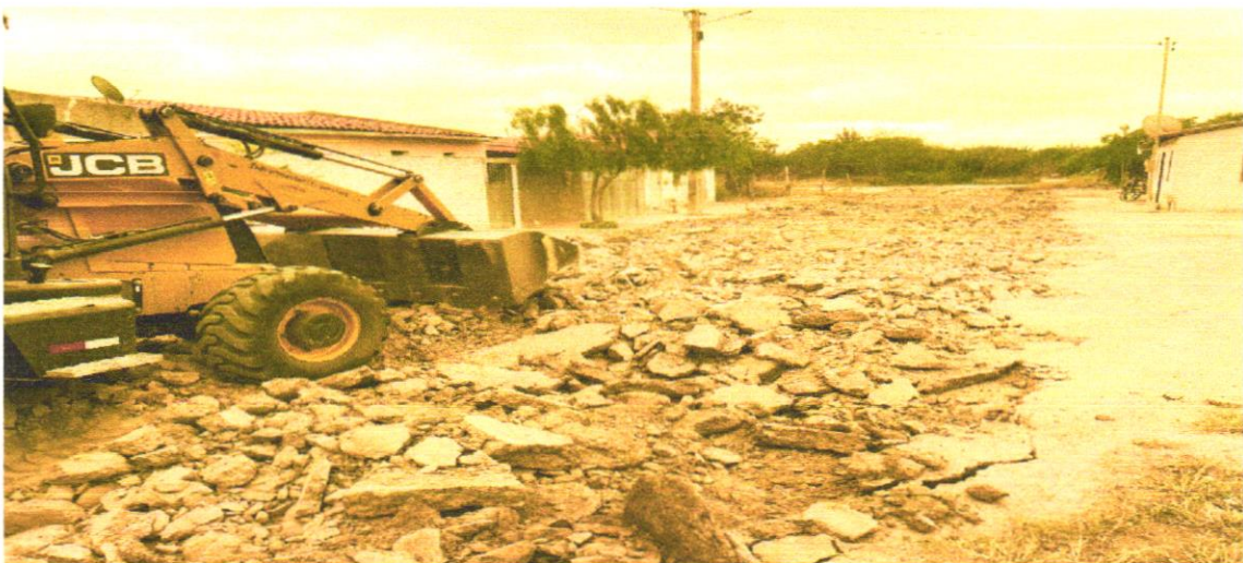
FOTO 02 REGULARIZAÇÃO E COMPACTAÇÃO
