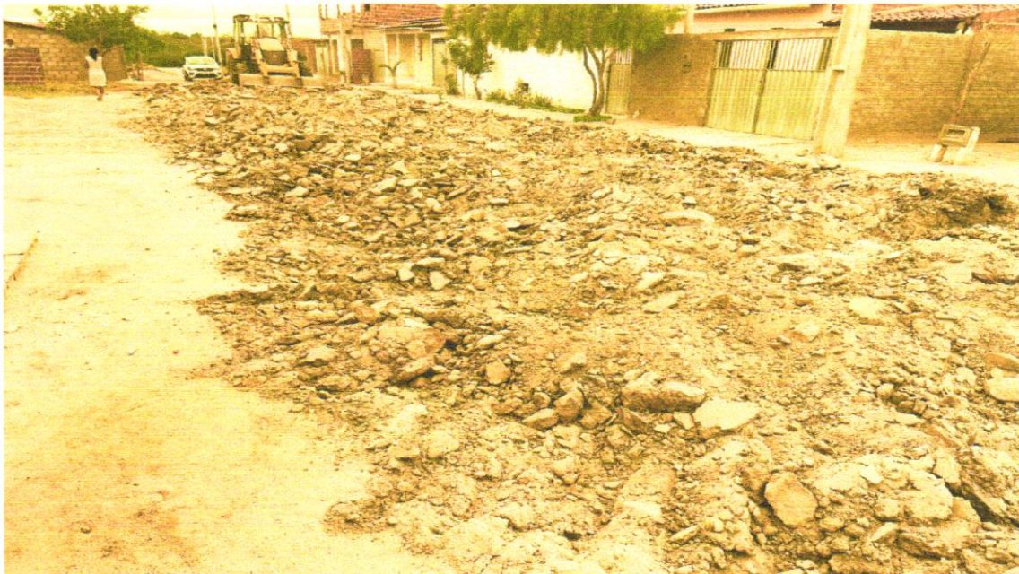
(FOTO 04) REGULARIZAÇÃO E COMPACTAÇÃO
