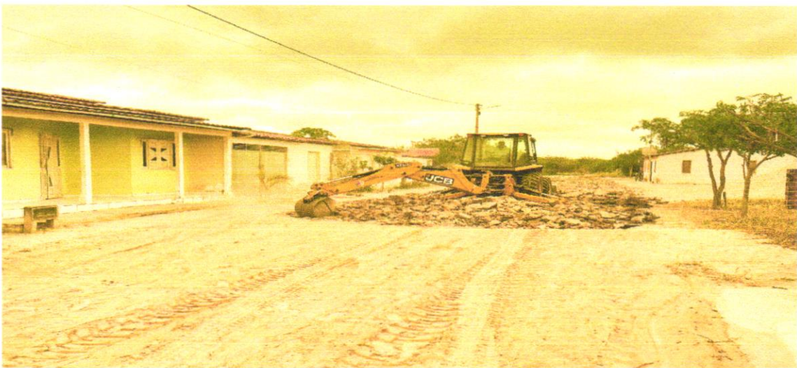
FOTO 01 REGULARIZAÇÃO E COMPACTAÇÃO
