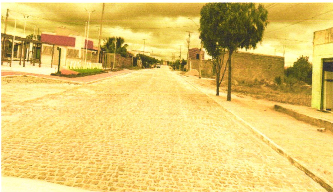
(FOTO 06) EXECUÇÃO DE PAVIMENTAÇÃO E MEIO FIO
