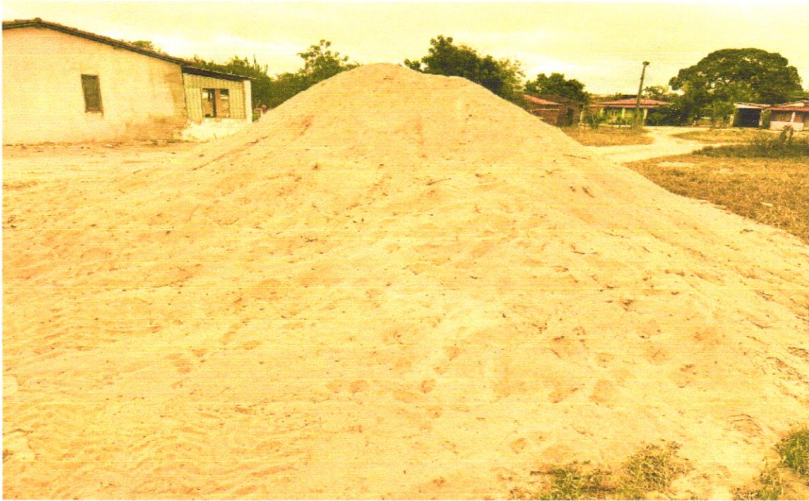
(FOTO 03) AREIA PARA COMPACTAÇÃO DO LEITO
